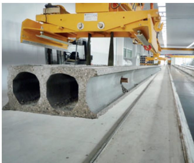
Remoção de uma laje alveolar protendida da pista de produção, por meio de uma travessa de elevação.
