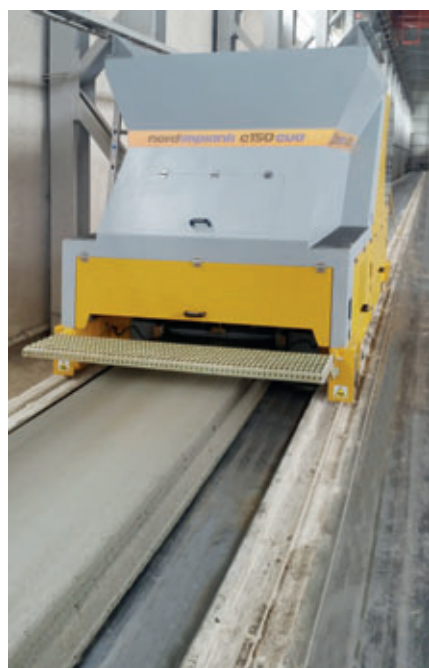
Extrusora na concretagem de uma laje alveolar estreita, de 900 mm de largura sobre uma pista padrão de 1.500 mm de largura.
