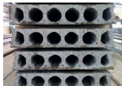
Uma laje alveolar protendida produzida com uma extrusora Nordimpianti, com uma largura de 1.100 mm.
