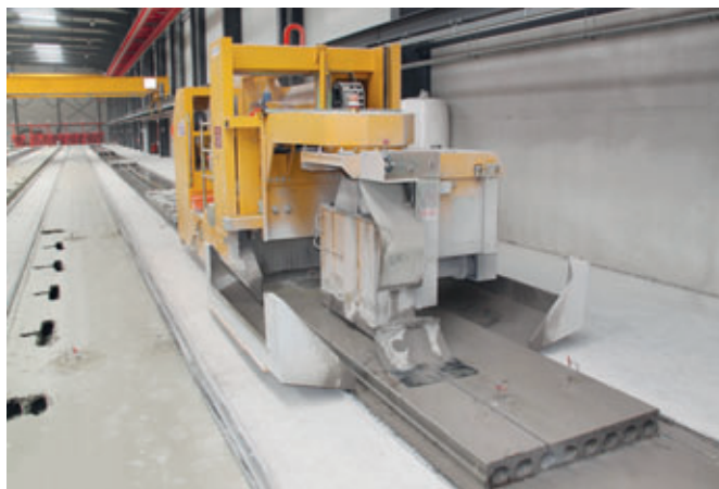
Corte de serra no sentido longitudinal de uma laje alveolar protendida curada, com uma serra de esquadria Universal, da Nordimpianti.
